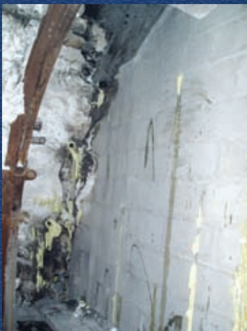
Těsnící injektáže proti únikům plynů na dole Hullera Vasco Leone, Španělsko 2006
