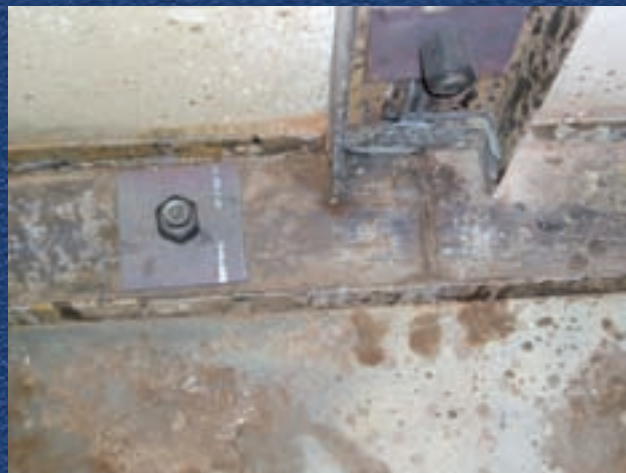
Mikropilotáže základů budovy
