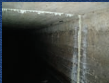
Těsnění a zpevnění okolí betonového převáděče vody pod hrází řeky Dunaje u obce Nové Selo, Srbsko, Vojvodina
