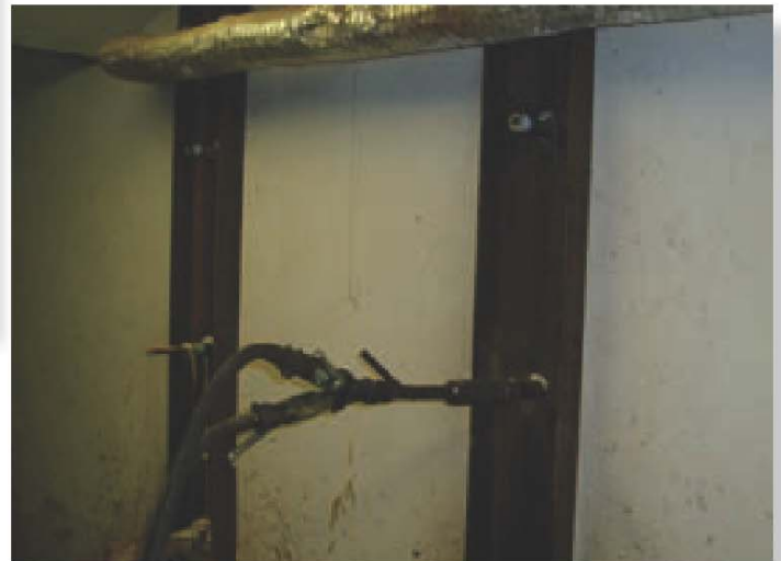
Kotvení ocelových konstrukcí a injektáže zdiva
