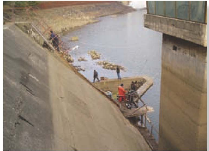
Těsnění hráže Berdu v Rumunsku
