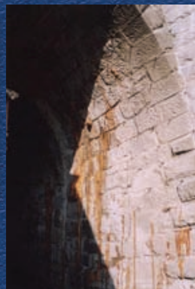
Injektáže kamenného mostu, obnovení vrubové izolace a zpevňování
