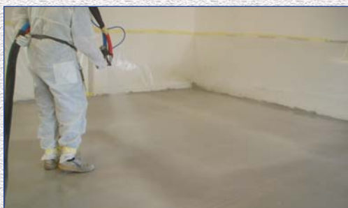
Nástřík izolační vrstvy
